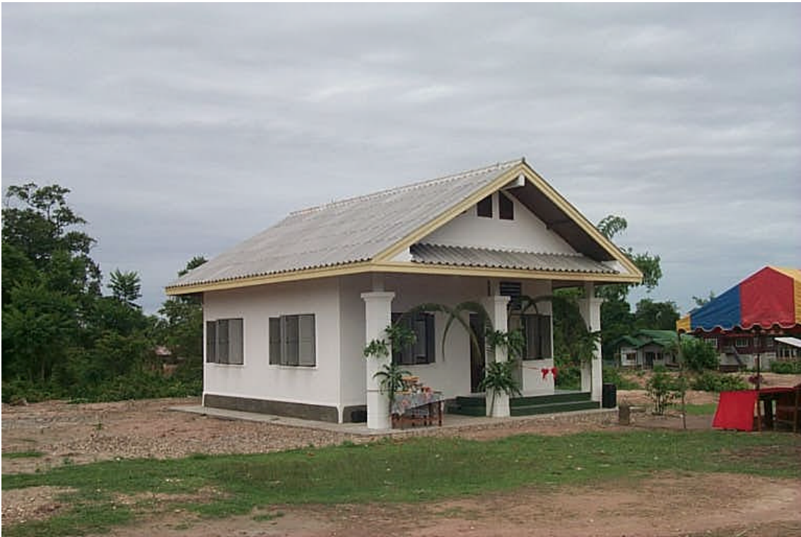
シエンダー村小学校敷地内に新設した図書館
