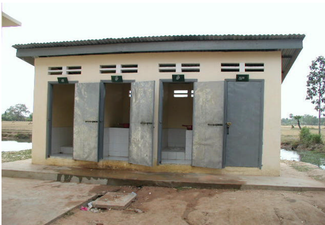
設置したトイレ
