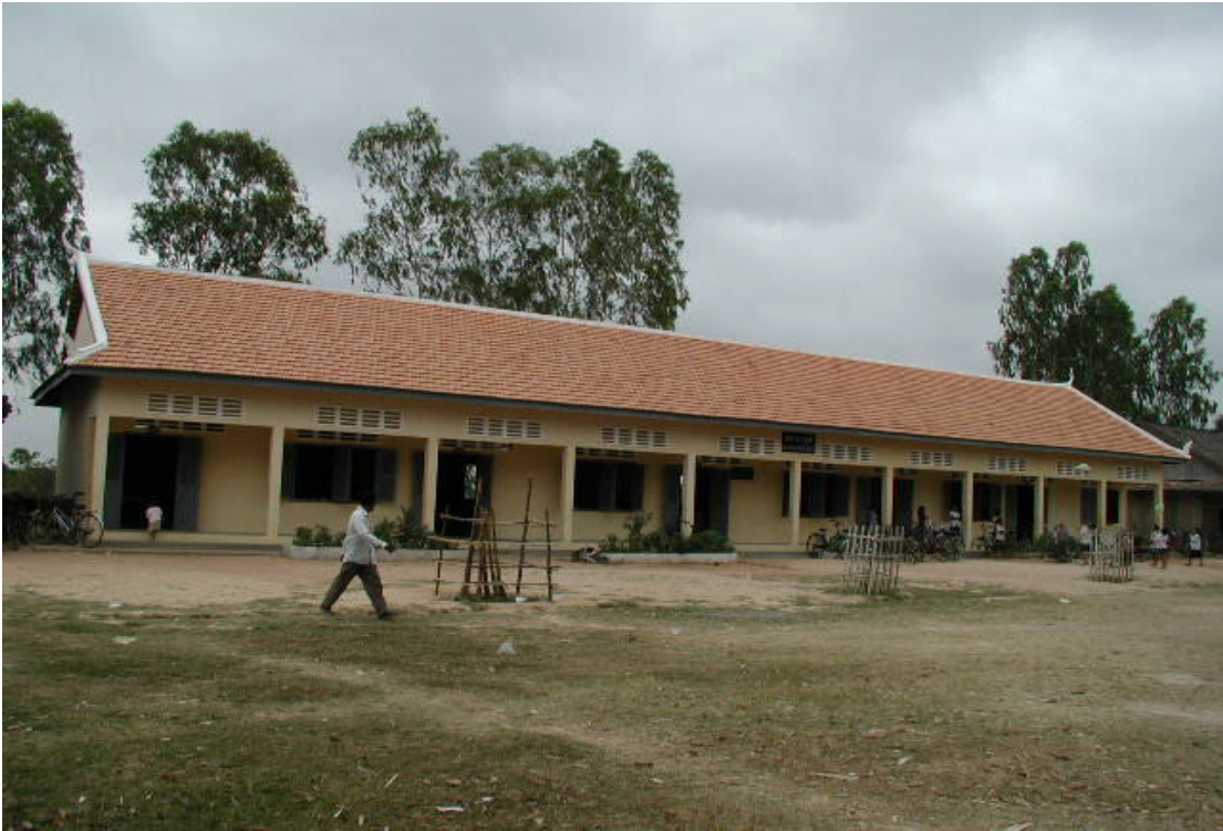
建設した校舎
