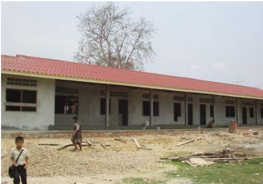
ポンシー第一小学校（旧校舎）修復の外観
