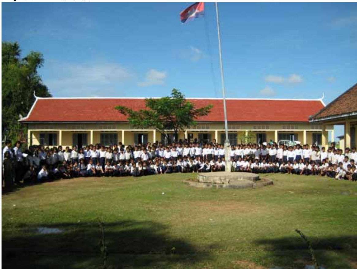
完成した校舎（正面）と教師、生徒
