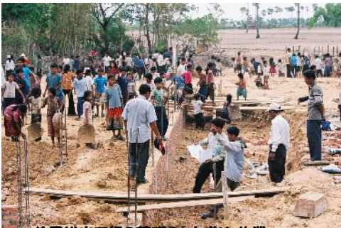
住民総出で行う基礎の「土盛り」作業
