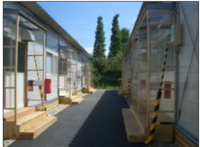
柏崎市内に建設された仮設住宅の様子
