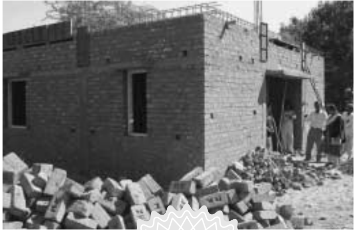
建設中の保育所
