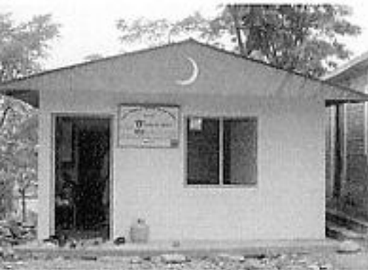
完成した仮設校舎
