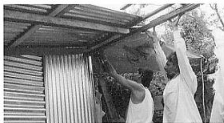
配布したトタン板を使用した家
