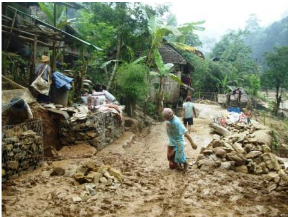
図書館へ続く階段と図書館前の道路修繕の様子
