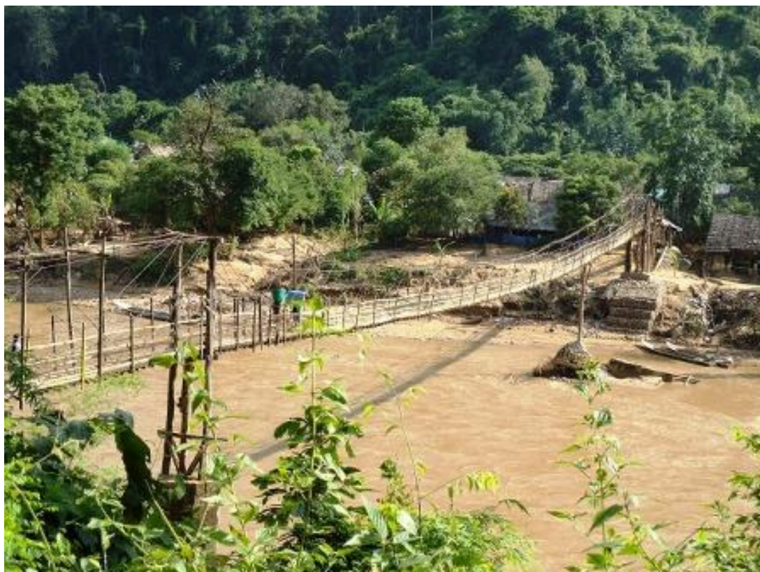
修復されたセクション7A とキャンプ中心部をつなぐ橋
