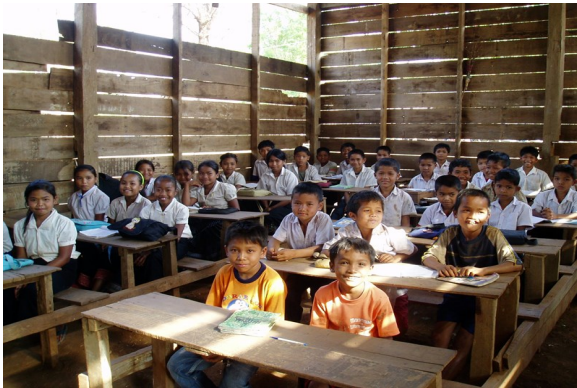
【老朽化した校舎】
