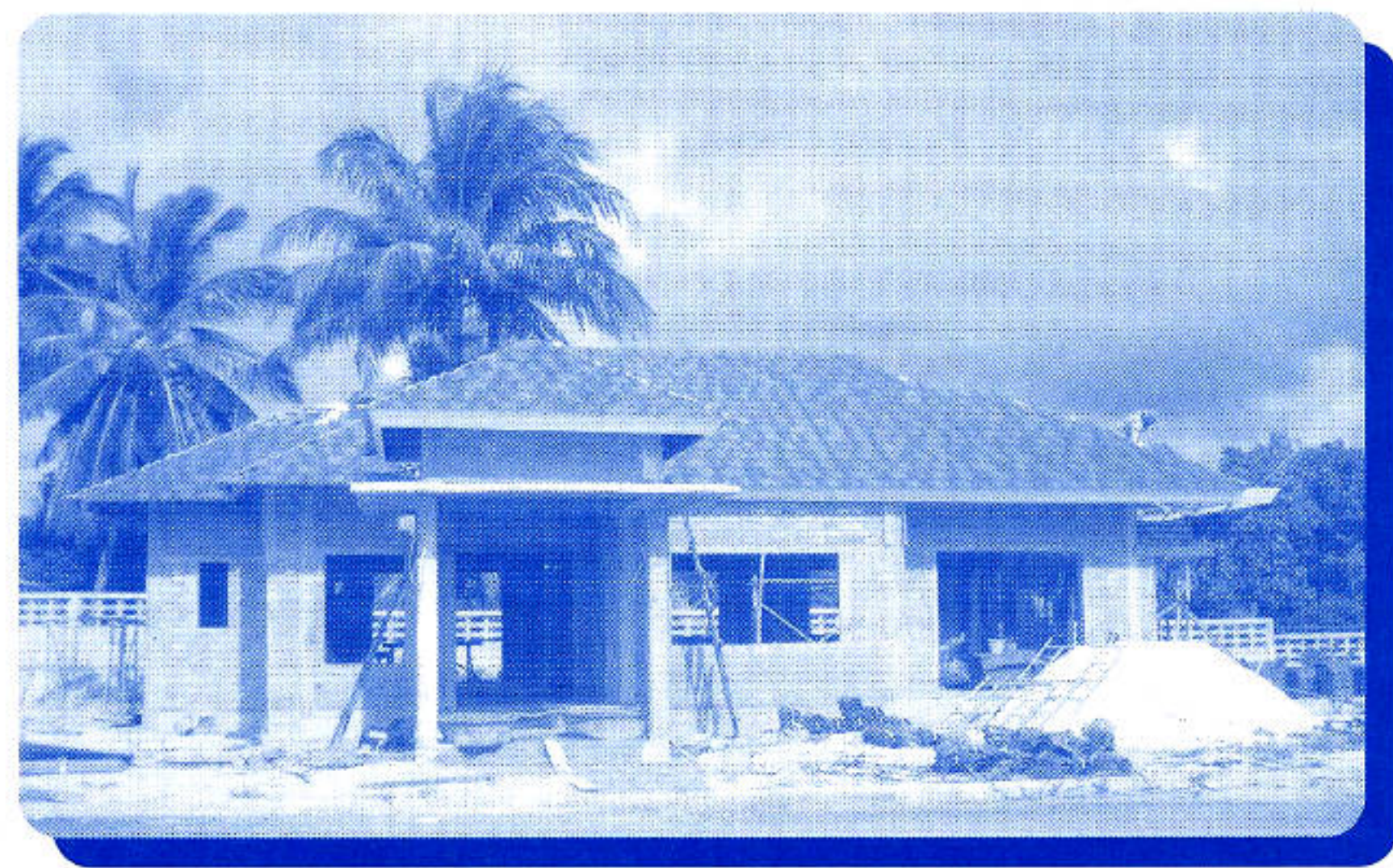
建設中のナイライ図書館／ターイムアン郡
