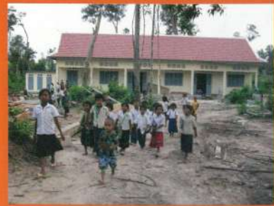
ボランティアこぶの会が 2007年に建てた新しい小学校
