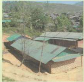
学校全景 斜面の限られた土地に住居が密集し、敷地が狭いため、校庭の場所が取れない。
