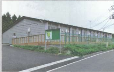
三浦さんが提供した土地に建てられた仮設住宅
