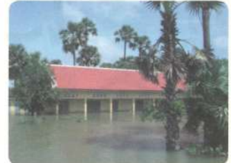
床上浸水で修繕が必要な学校は27校にのぼった
