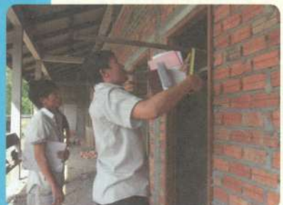
ドア枠の設置状態を確認しているところ
