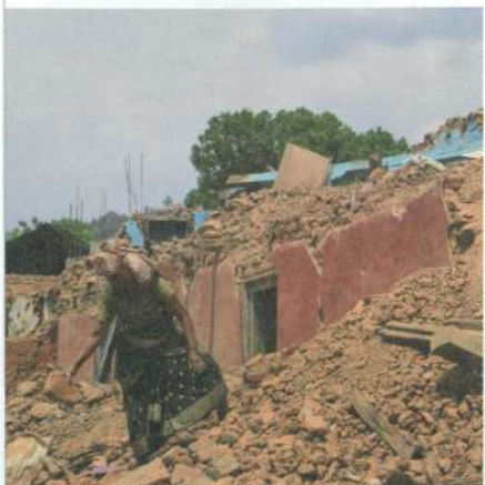
ヌワコット郡 倒壊した家屋
