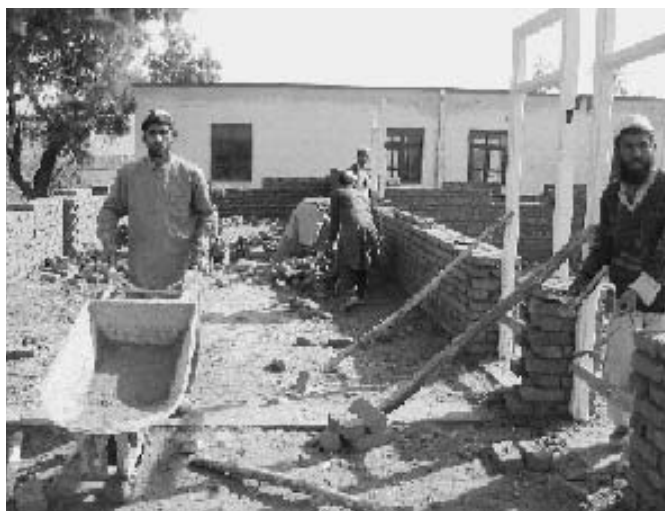
学校建設の様子
