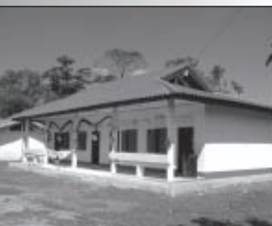
リソースセンター建設
