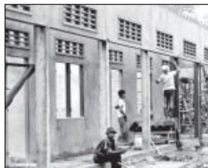
建設中の小学校
