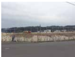
中心市街地の盛土工事。浸水した土地を数メートル高上げて再び人が住める街を作る。場所によって10メートル以上盛土工事を行う。
