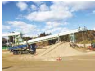
山を削って土砂を搬出するベルトコンベアー。トラックで土砂を搬出するよりも工期が短縮されるため、各自治体で導入されている。
