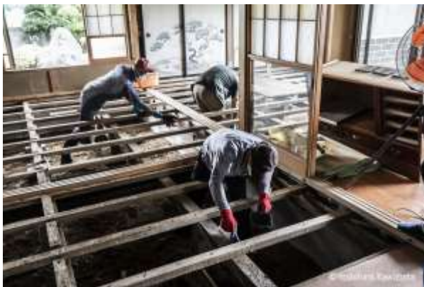
被害を受けた民家で泥を落とす大人たち （山形県飯豊町）
