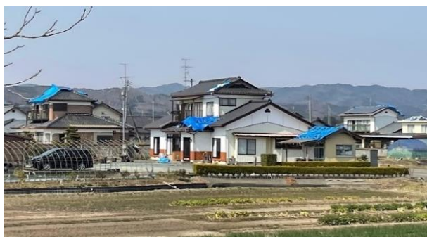
ブルーシートで保護された被災家屋(鹿島区)
