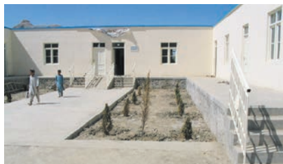
最初に建設した小学校(新築当初)
