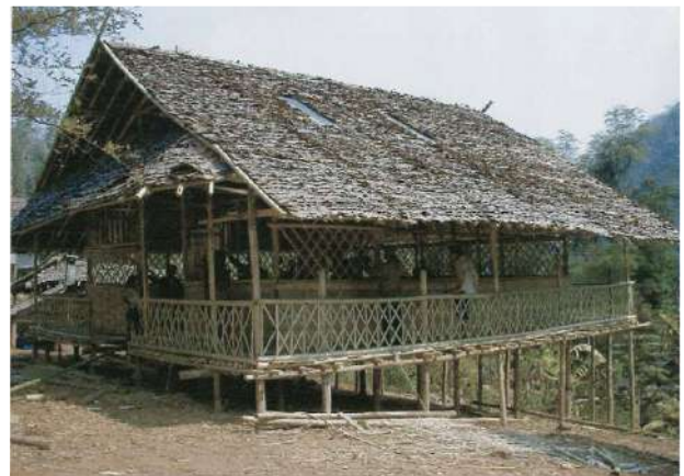
メラマルアン第一図書館外観
