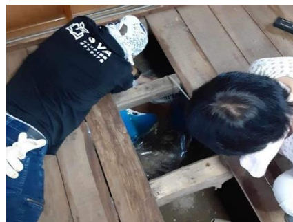
浸水した家屋への調査の様子
