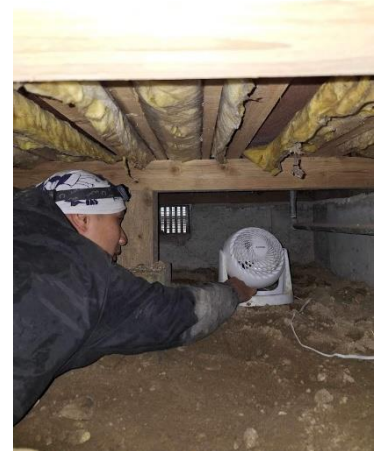
浸水した家屋へ送風機を設置
