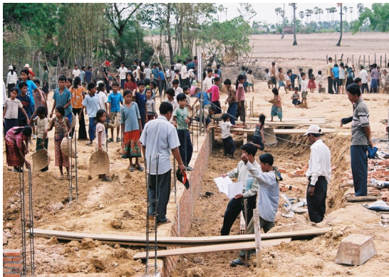
住民総出で行う基礎の「盛り土」作業
